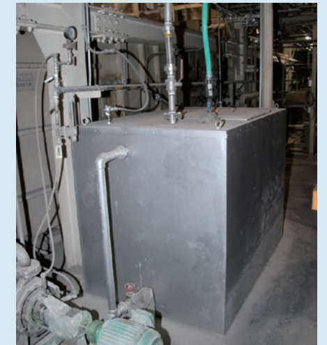
▲純水加温槽(熱交換器を使用)
